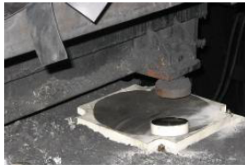
사진2 베이스플레이트 설치후 마블베어링과의 조립
